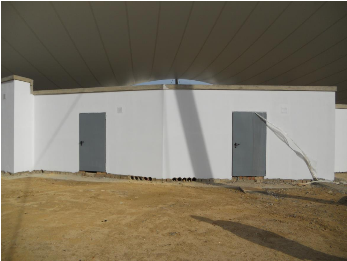
ZONA A, TRAMO M7-M6, M6-M5
