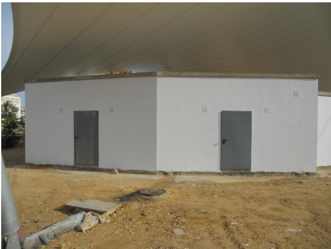
ZONA A, TRAMO M9- M8, M8-M7
