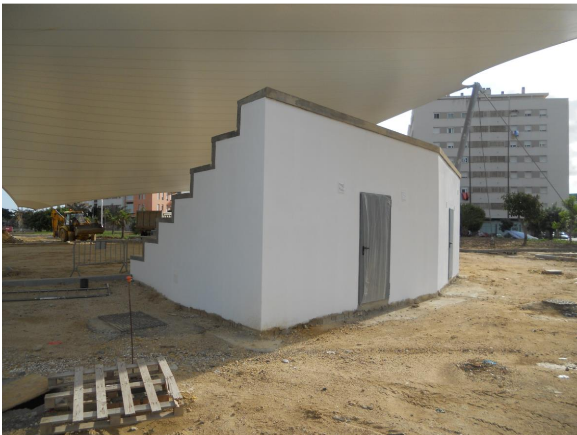
ZONA A, TRAMO ESCALERA A, TRAMO M9-M8
